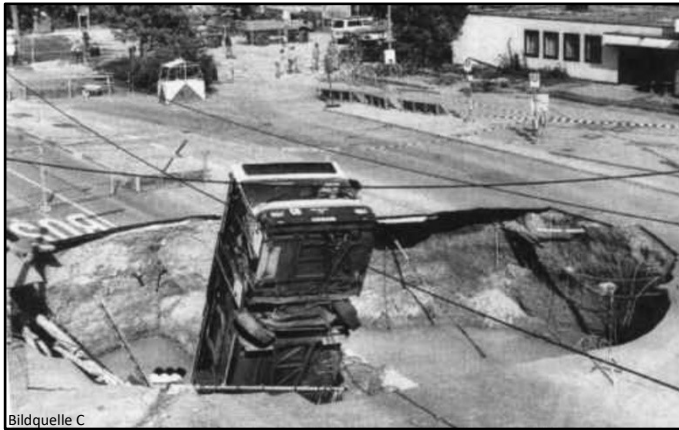
U-Bahn-Baustelle Bahnhof Trudering - Tunneleinbruch
